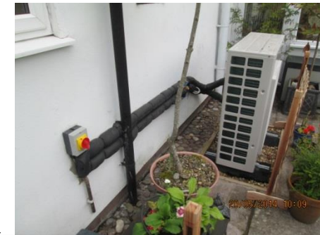
Bombas de Calor
